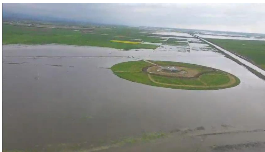
شکل ۲۸- آب‌گرفتگی محدوده فرودگاه گرگان در مجاورت باند و لزوم احداث سازه‌های محافظ سیلاب
