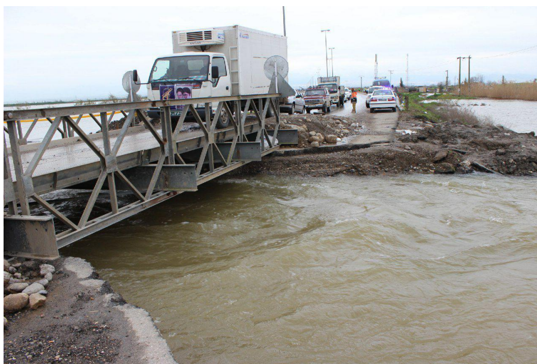
شکل ۲۵- تسریع تخلیه آب با برش های جاده ای (این پل فلزی بعد از برش نصب شده است)
